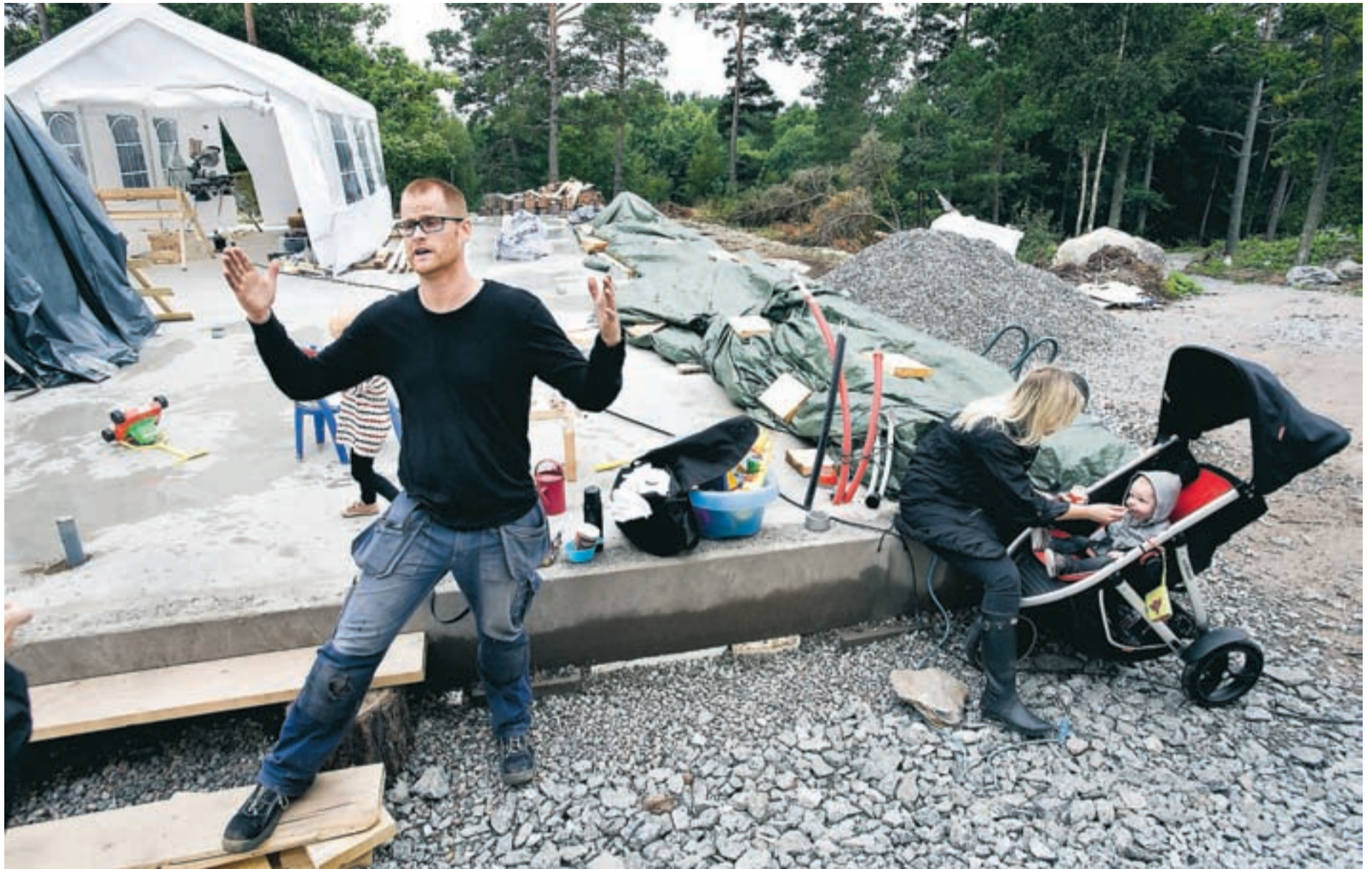
Betonggrunderna för hus och gäststuga står klara på familjen Edelströms tomt vid Mälaren. Målet är att få klart det mindre huset i år, så att de kan bo nära bygget nästa sommar. Husen har de ritat själva, och det mesta snickrandet görs också på egen hand.
